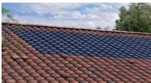
*Capteurs intégrés dans les tuiles.*
