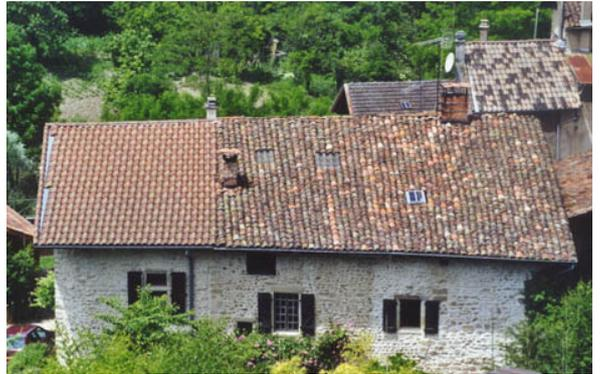
*tuile canal à emboîtement et tuile canal*
